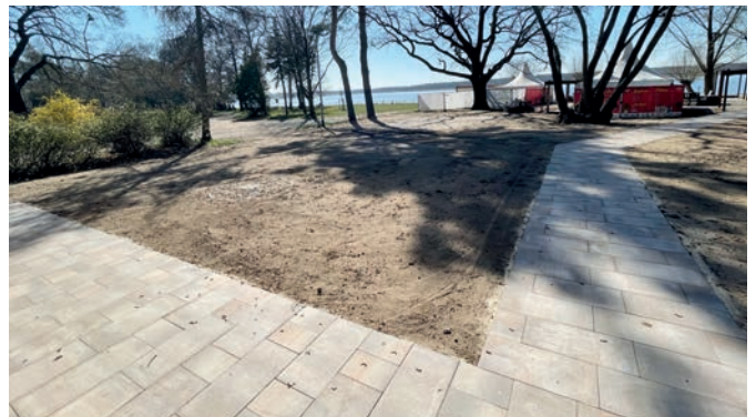
Die Außenanlagen rund um den neuen Sanitärcontainer im Strandbad sind fertiggestellt...
