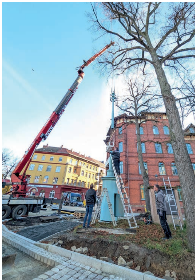
Am 5. November wurde die durch das Unternehmen Metallbau Andres restaurierte Litfaßsäule mit Hilfe des Kranservice Gerd Heubaum wieder an ihren Platz in der August-Bebel-Straße gebracht und aufgestellt.
