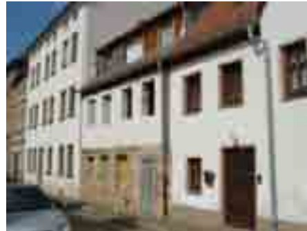
Lorenzstraße 3 Modernisierung von Wohnraum
