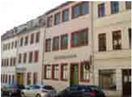
Brauereimuseum, Fischerstraße 11 ehem. Wohnhaus mit mittelalterlichen Bierkeller
