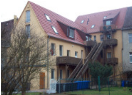
Rückseite Leipziger Straße Balkonanlagen
