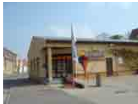
Elbstraße Malerfachhandel, sanierter Flachbau
