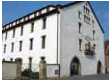
Heimerer Schulen, Schloßstraße 26 ehem. Zeughaus
