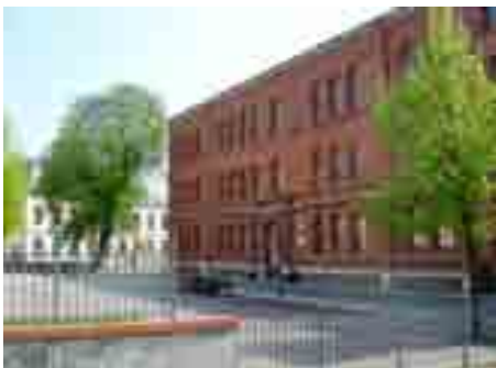
Grundschule an der Promenade 1 denkmalgerecht sanierter Klinkerbau
