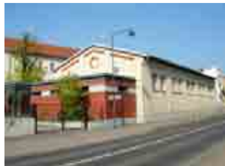
Sporthalle, Straße der Jugend Kombination aus neu und alt, saniert
