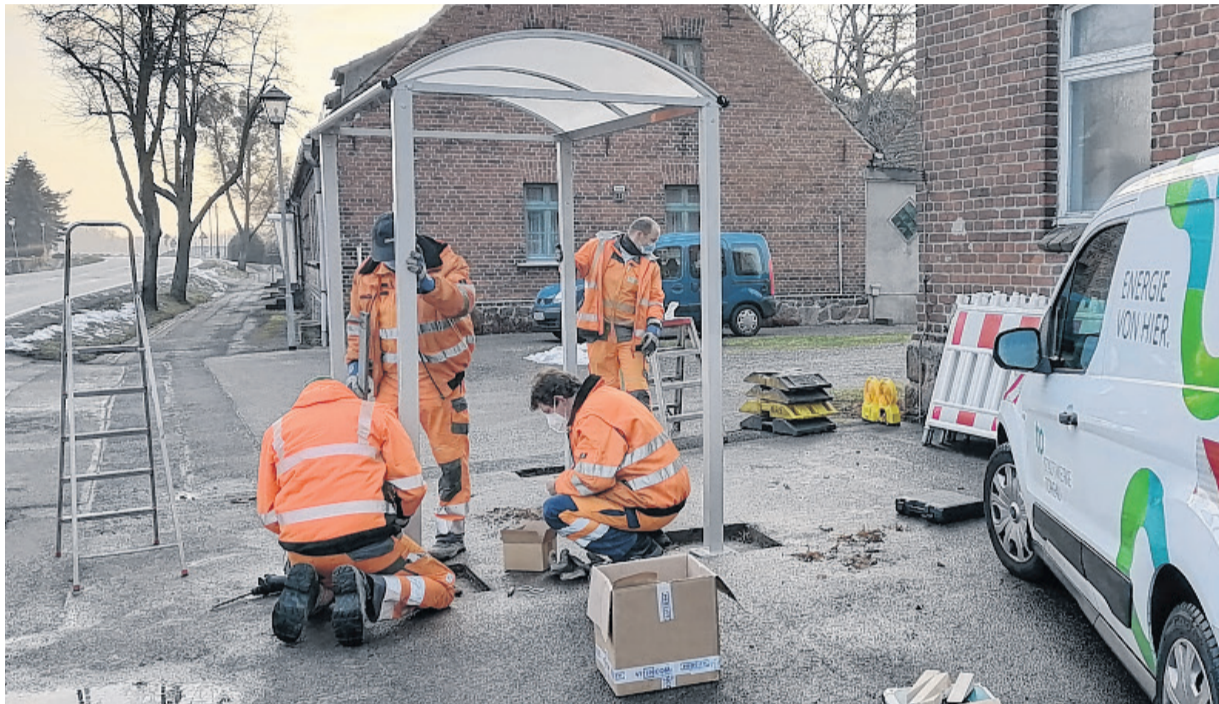
Mitarbeiter der Torgauer Stadtwerke bauten den neuen Fahrgastunterstand in Graditz Anfang dieser Woche auf. Fotos: Stadt Torgau
