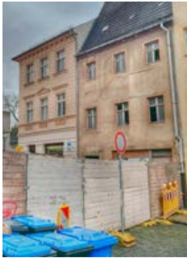
Die Sperrung in der Wittenberger Straße ist im März Geschichte. Foto: Stadt Torgau
